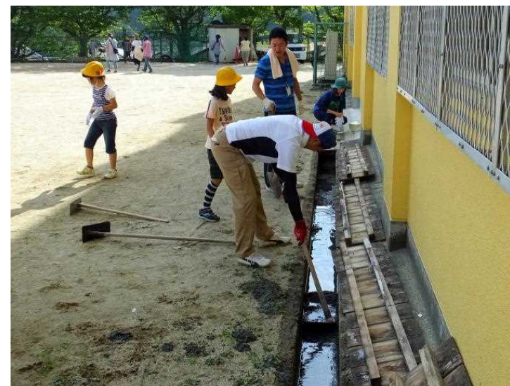
8月20日 溝の土砂のかき出し作業
